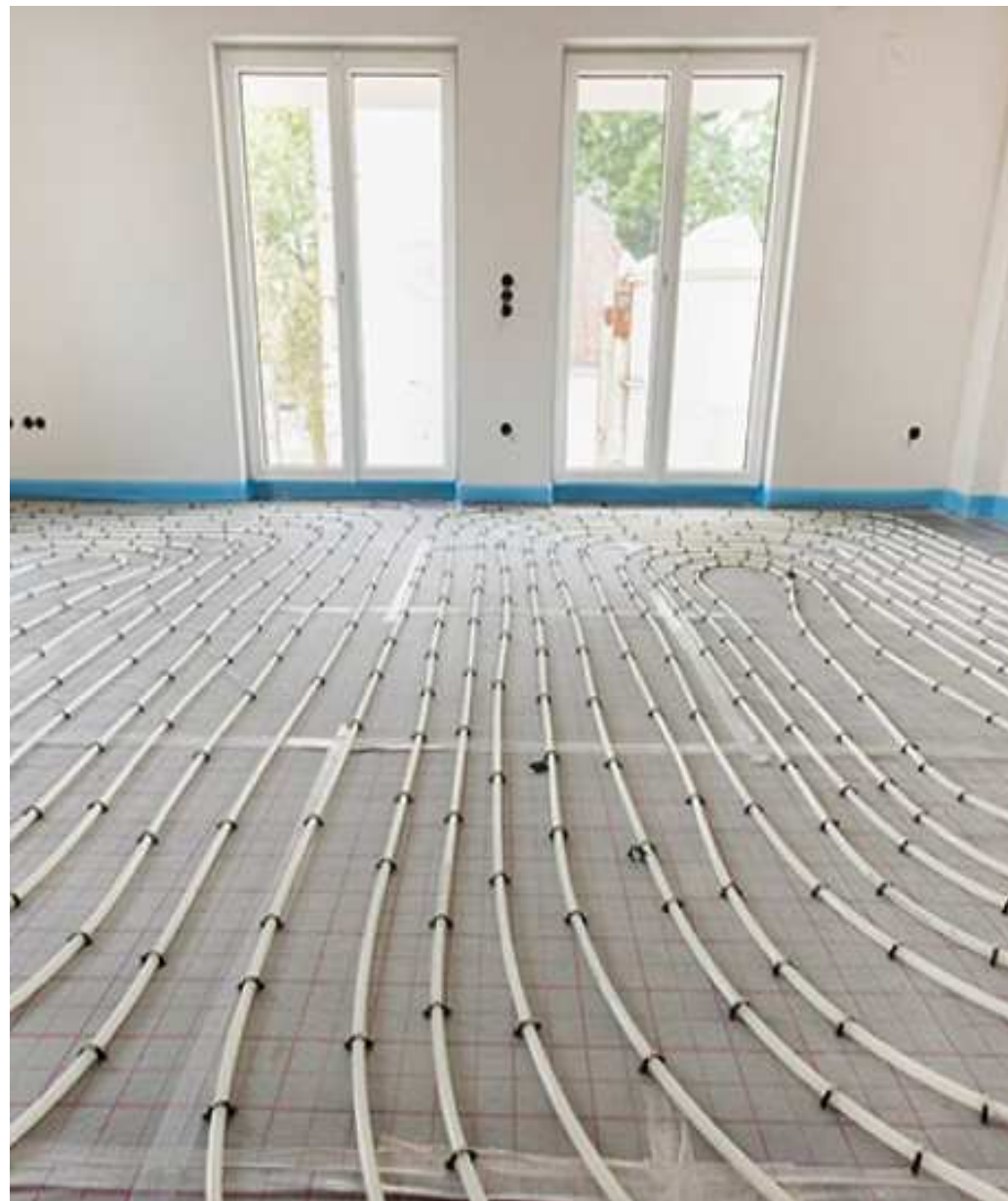
RISCALDAMENTO A PAVIMENTO
