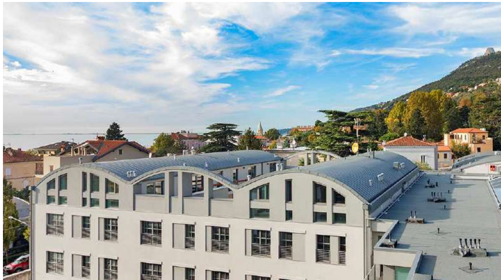
VISTA COMPLESSIVA COPERTURA
